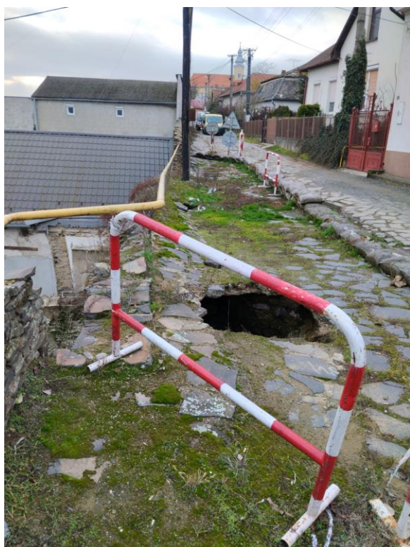
Kráľovský Chlmec: v dôsledku povodne prepadnutá cesta a poškodený oporný múr
